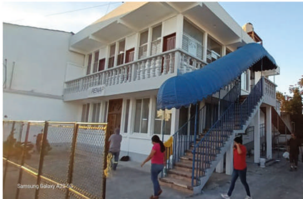
Trabajos de infraestructura en la Oficina del RENAP de Poptún, Petén (después)
