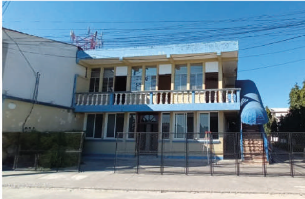
Trabajos de infraestructura en la Oficina del RENAP de Poptún, Petén (antes)
