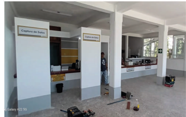
Trabajos de infraestructura en la Oficina del RENAP de Poptún, Petén (después)
